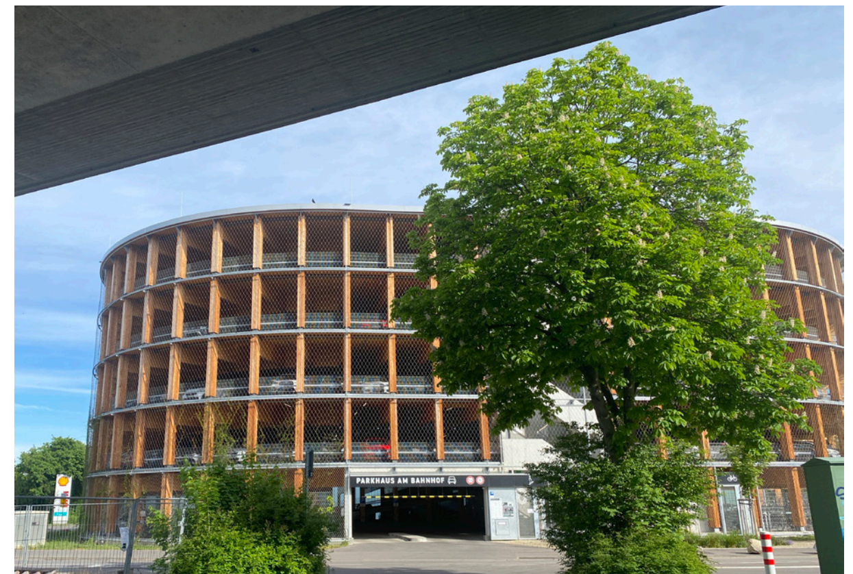
Abbildung 14, Holzparkhaus von Außen Quelle: Eigene Darstellung
